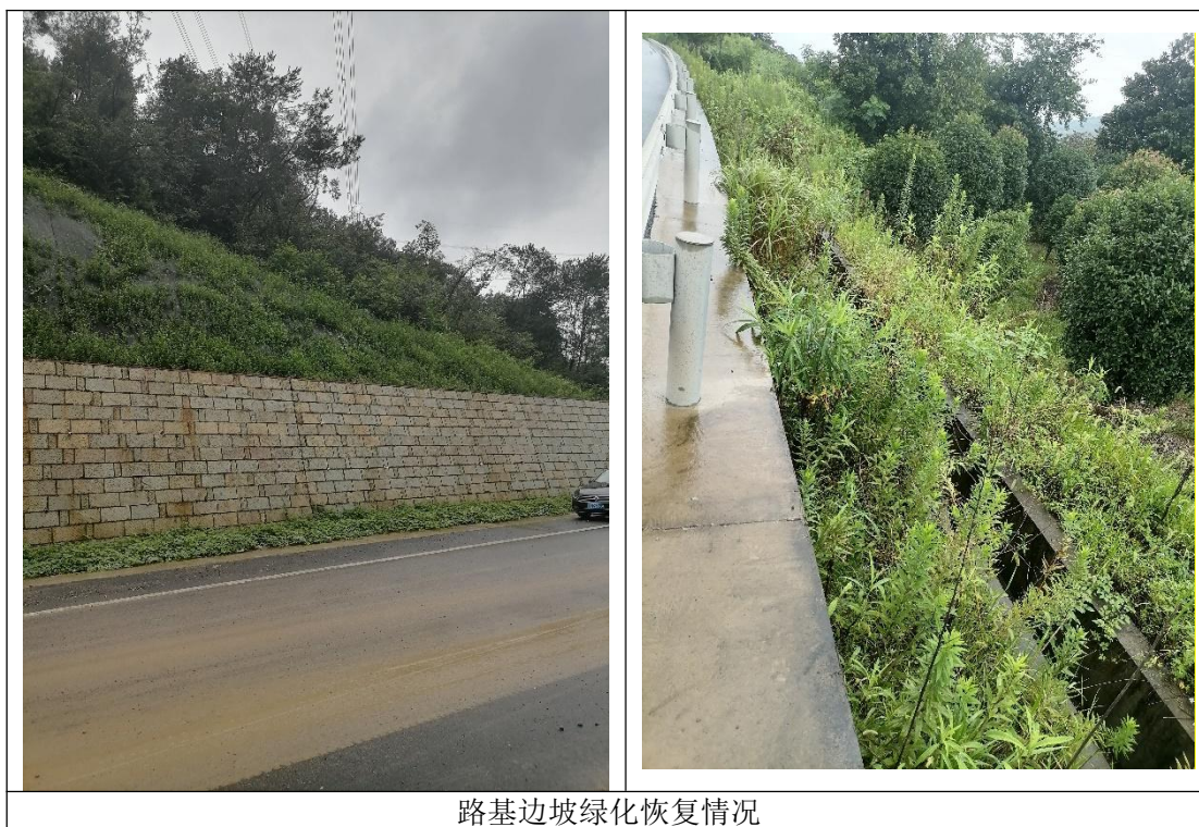
图 6.2-1 永久工程占地绿化恢复情况
